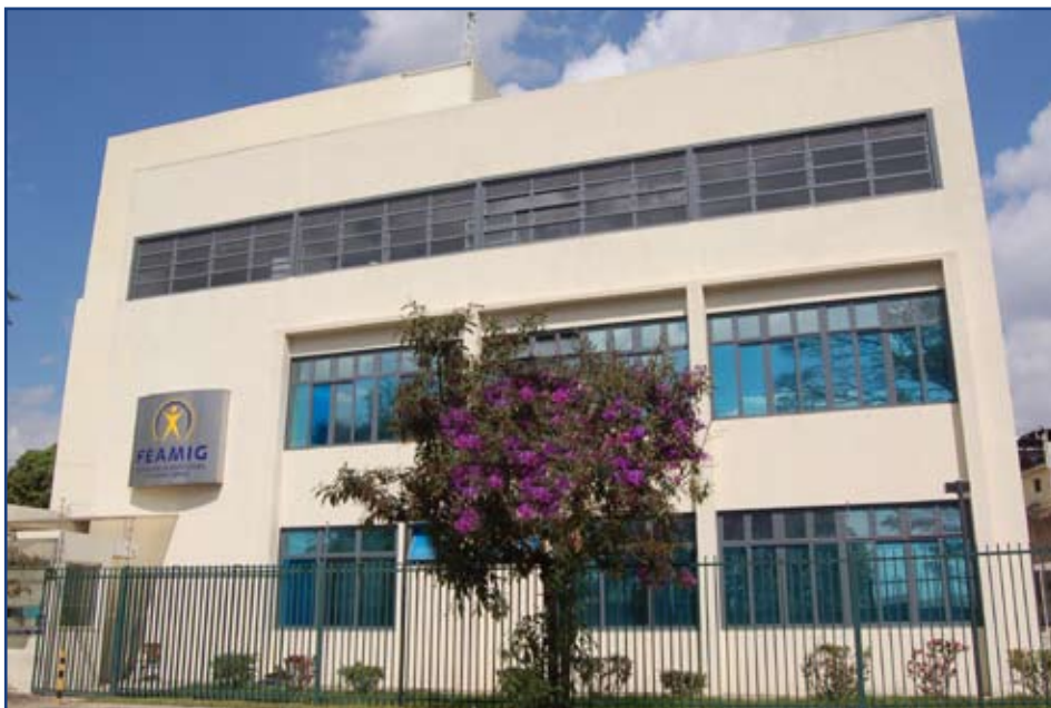
Prédio da Unidade Gameleira da FEAMIG
